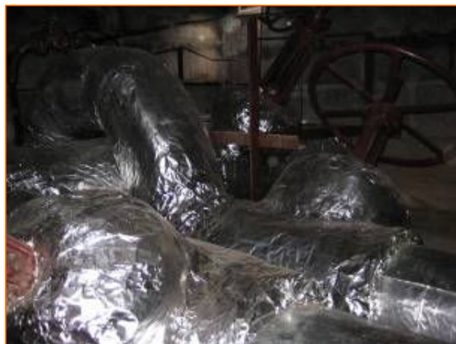
Фото 3. Тепловая камера, покрытая фольгированными теплоизоляционными конструкциями СТУ
