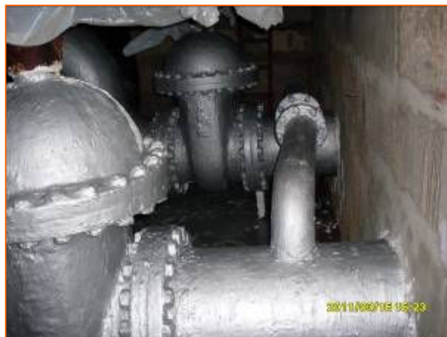
Фото 1. Тепловая камера, покрытая теплоизолирующим покрытием типа «полые микросферы-полимерное связующее»
