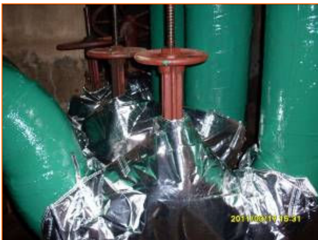
Фото 4. Тепловая камера, покрытая пенополиуретановыми скорлупами с дополнительной гидрозащитой.
